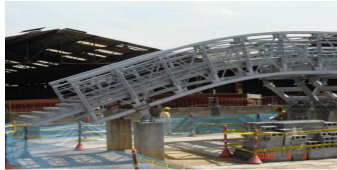
FABRICACIÓN E INSTALACIÓN ESTACIONES DE TRANSMILENIO (CONSORCIO BOGOTÁ)
