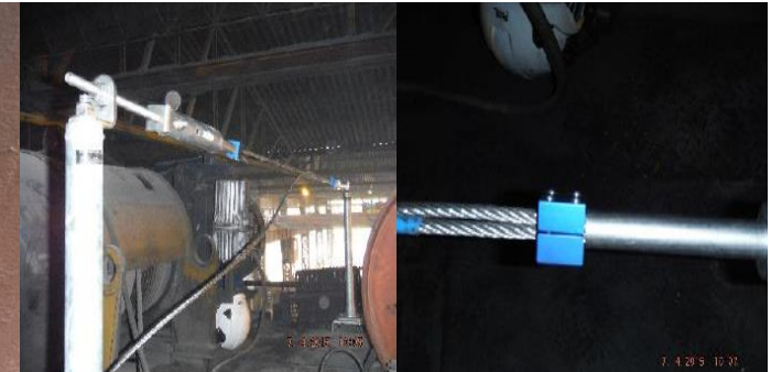
INSTALACIÓN LINEAS DE VIDA HORIZ. Y VERT -PUNTOS DE ANCLAJE CERTIFICADOS (GERDAU DIACO PLANTAS MUNA, TOCANCIPA, DUITAMA, YUMBO, TUTA)
