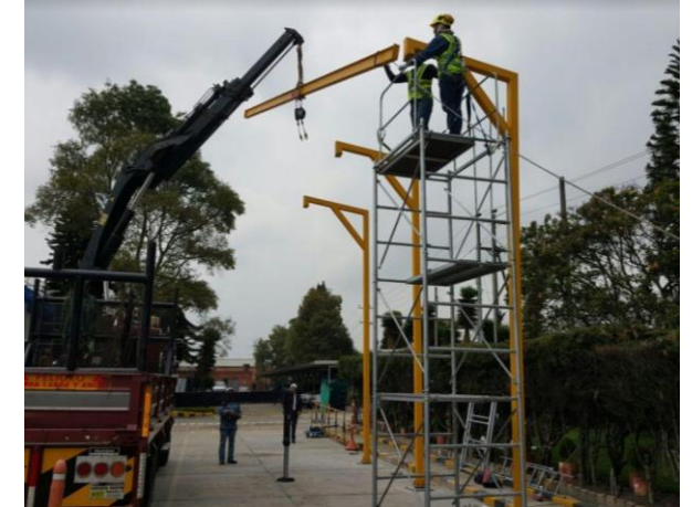
FABRICACION E INSTALACIÓN DESCARGADEROS SAINT GOBAIN (MADRID)
