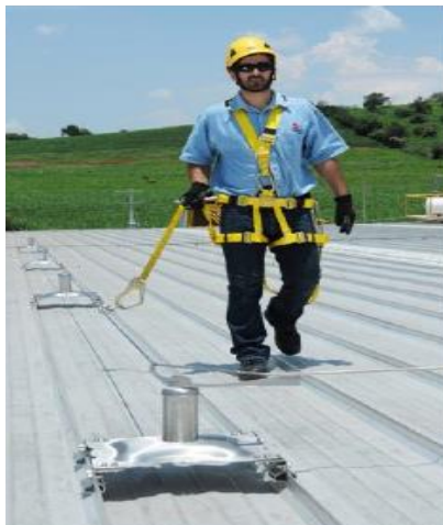
LÍNEAS DE VIDA SOBRE CUBIERTA (BIMBO – TENJO)
