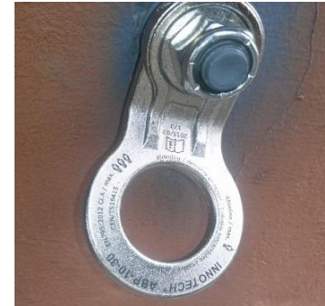
INSTALACIÓN LINEAS DE VIDA HORIZ. Y VERT -PUNTOS DE ANCLAJE CERTIFICADOS (GERDAU DIACO PLANTAS MUNA, TOCANCIPA, DUITAMA, YUMBO, TUTA)
