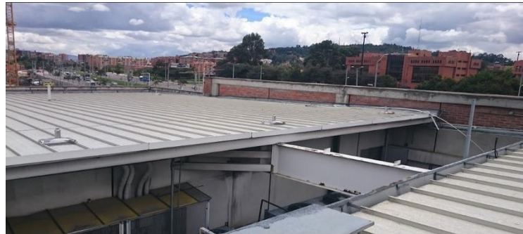
INSTALACIÓN LINEAS DE VIDA CUBIERTA GRUPO ÉXITO
